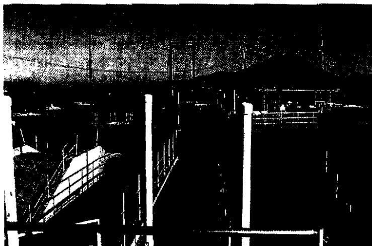
Planta Internacional de Tratamiento Secundario de Nogales
