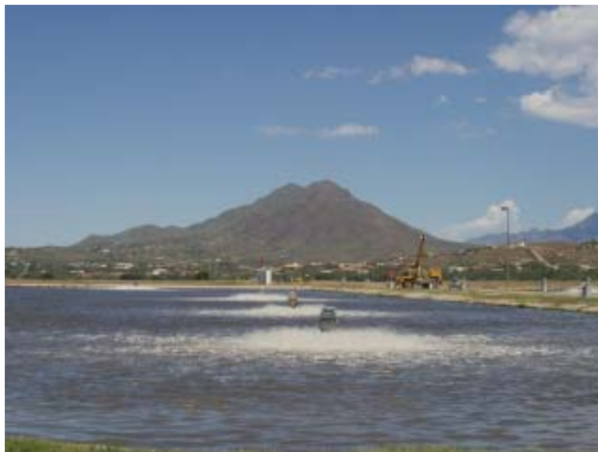
Planta Internacional de Tratamiento de Aguas Residuales de Nogales
