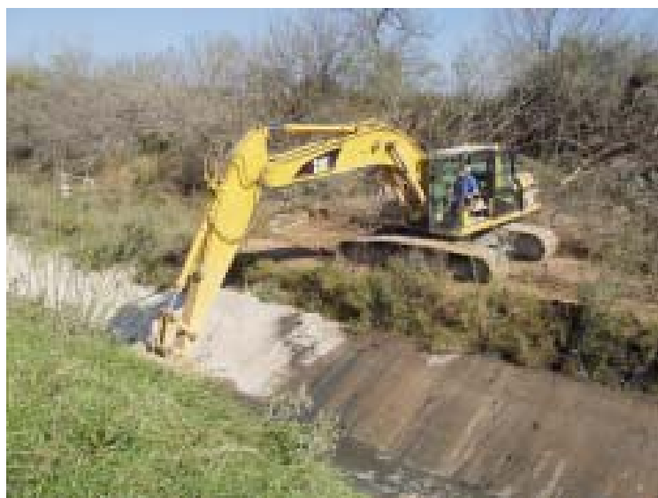
Mantenimiento del Dren El Morillo
